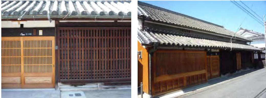
写真 10 保存型の事例 旧来通り復元・修繕されている例
