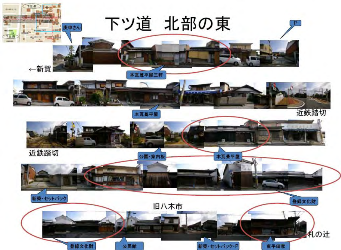
図5 町並みの連続立面写真で現状把握
